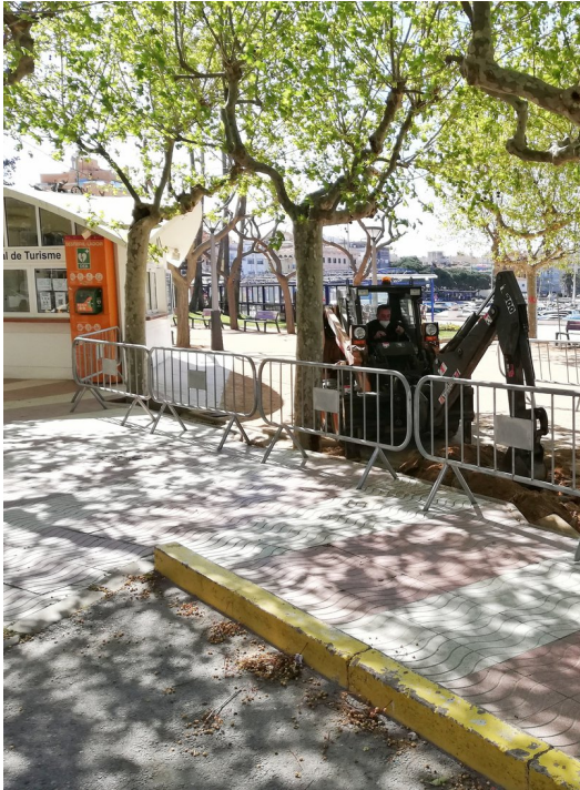
Un operari de la brigada municipal inicia els treballs a la zona del passeig del Mar, a Palamós J. TRILLAS.
