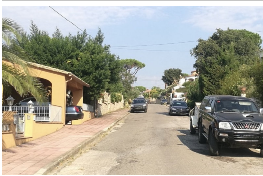
La degradació dels carrers de la urbanització Mas Pere de Calonge era evident J.TRILLAS.
