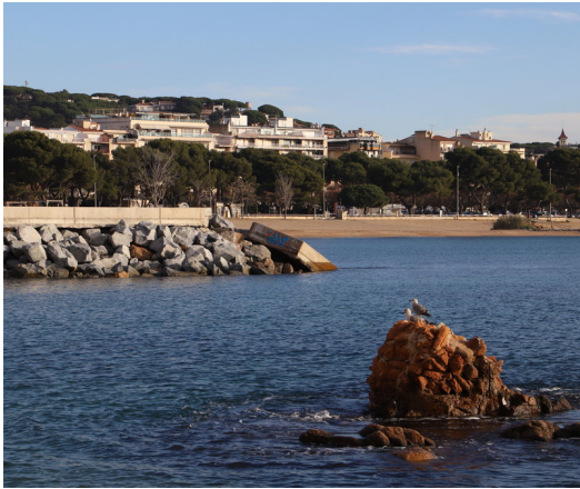
La punta del mirador sobre l'espigó del moll de pedra guixolenc, escapçada pel 'Glòria' i que els ajuts no cobreixen per manca de concessió E.A.
