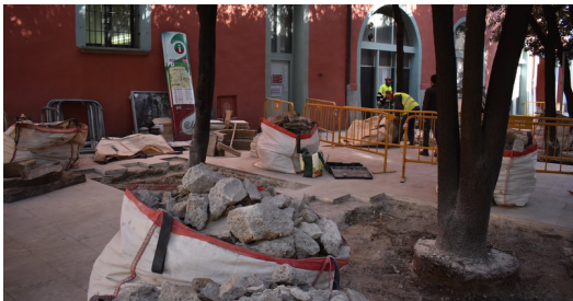
Les obres a la plaça del Carme, centrades de moment en el trasplantament d'arbres, aquesta setmana R.E.
