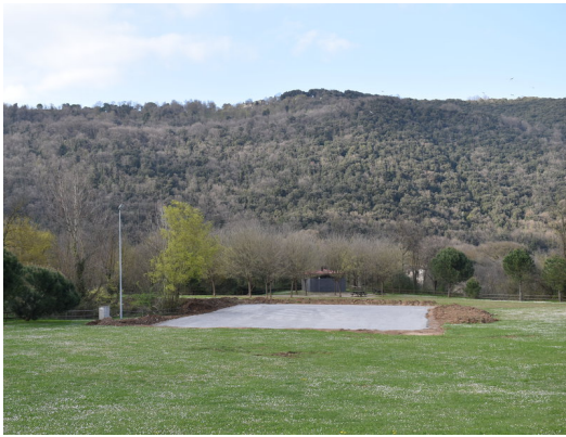
El lloc on es farà la pista. El moviment de terres ja està acabat. R. E..
