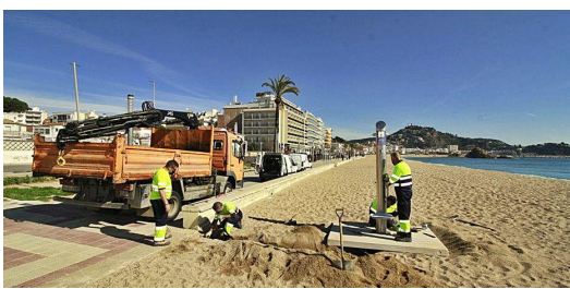
Els operaris municipals instal·lant les dutxes.
