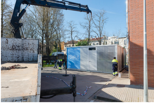
Instal·lació del nou mòdul Covid al CAP de Llagostera
