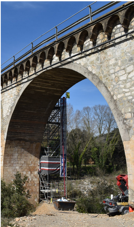
La bastida de les obres en un lateral del viaducte, la setmana passada R.E.
