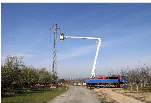
Operaris d'Endesa substitueixen elements d'una torre elèctrica per a evitar que hi xoquin les aus. | @Endesa.
