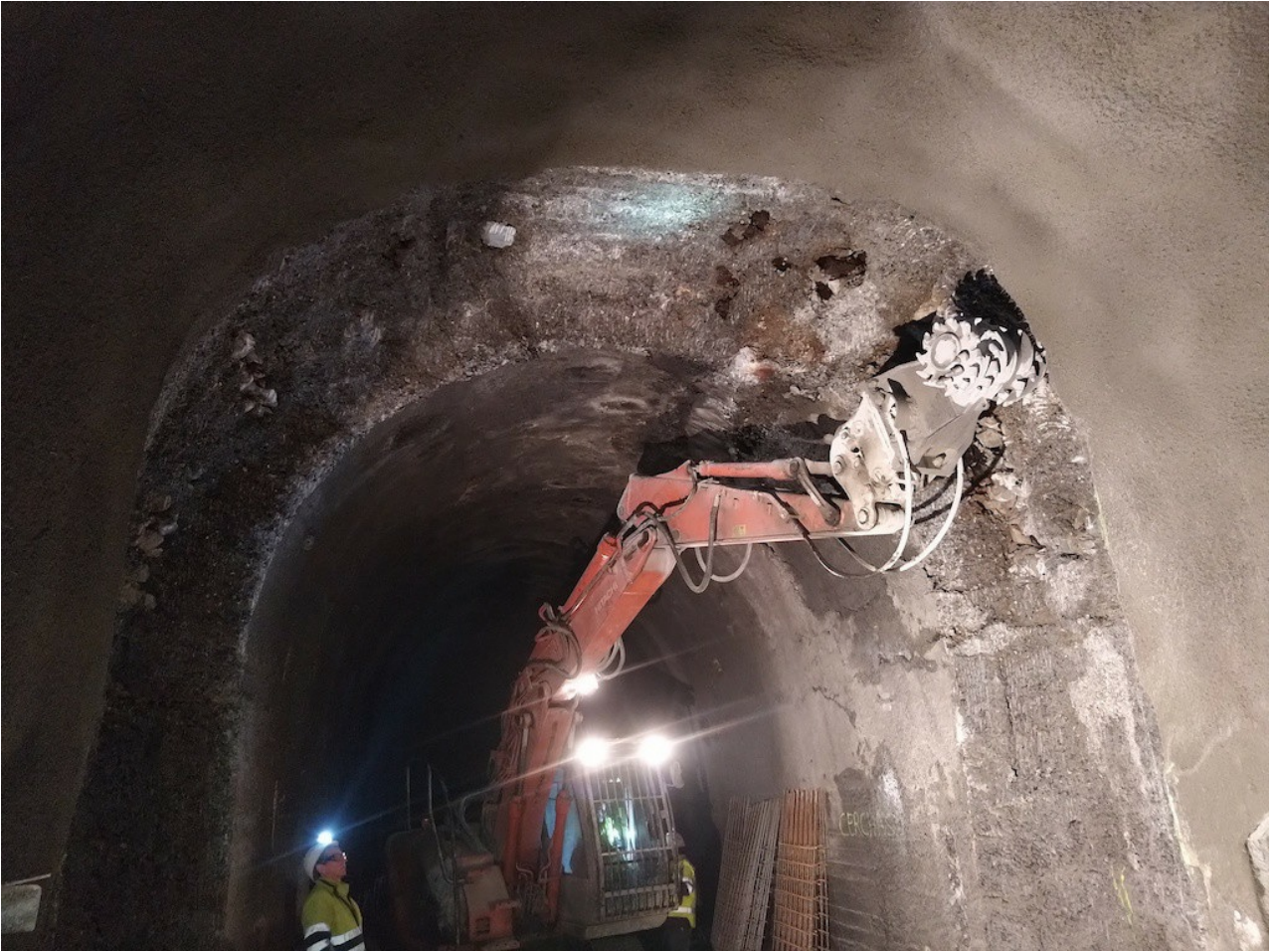
Treballs a l'interior del túnel de Toses, durant les obres de millora | Foto: Adif
