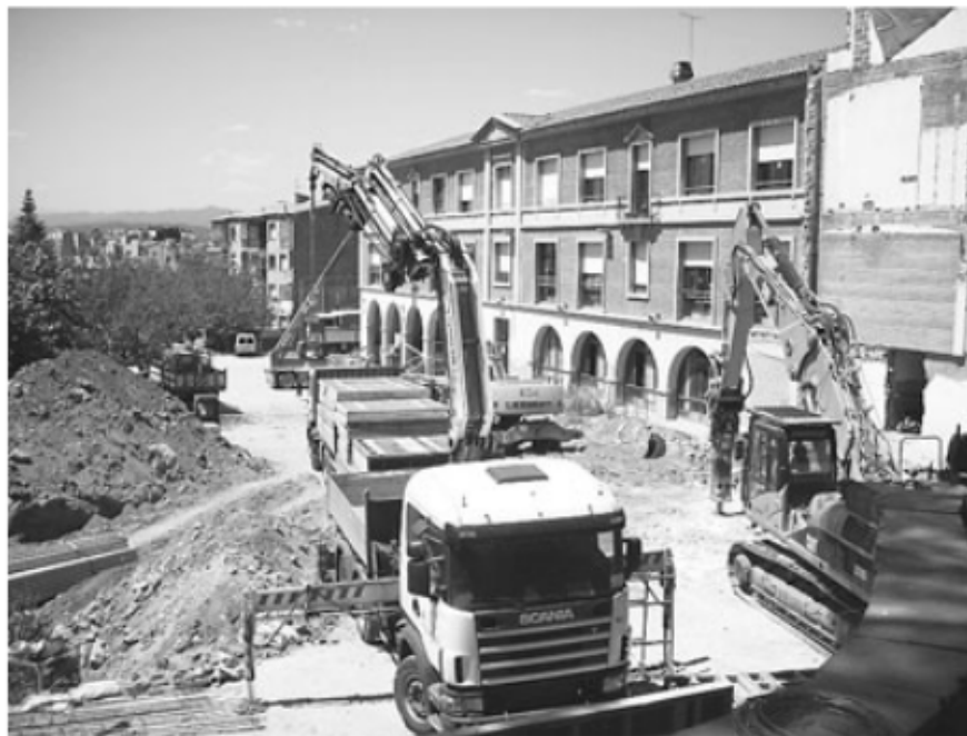
Tot el pati de l'escola Annexa de Girona està ocupat per les obres d'ampliació. / D.V.
