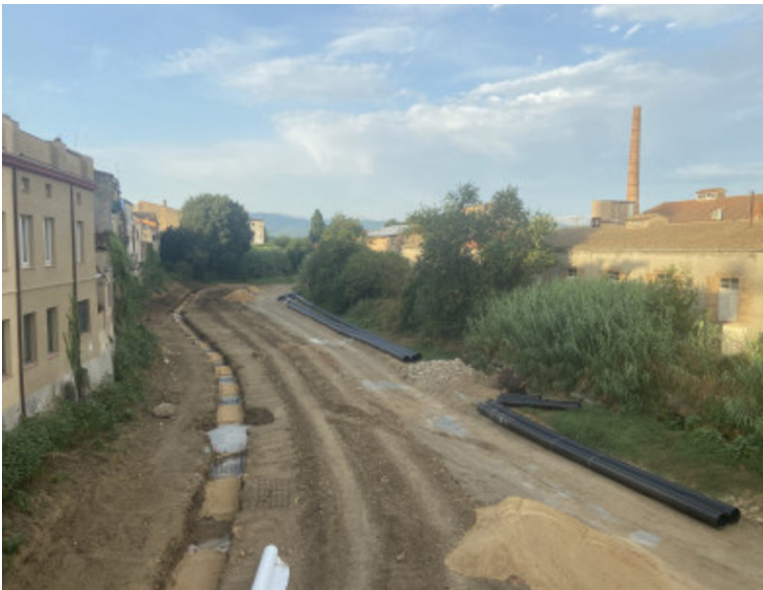
La zona on es fan les obres del col·lector AJUNT. BISBAL.
