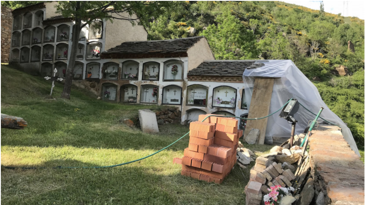
Obres al mur del cementiri de Toses | Xevi Pujol
