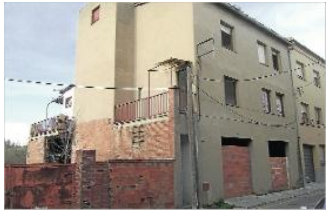
Façana del número 49, sense cap finestra convencional. carles torramadé
