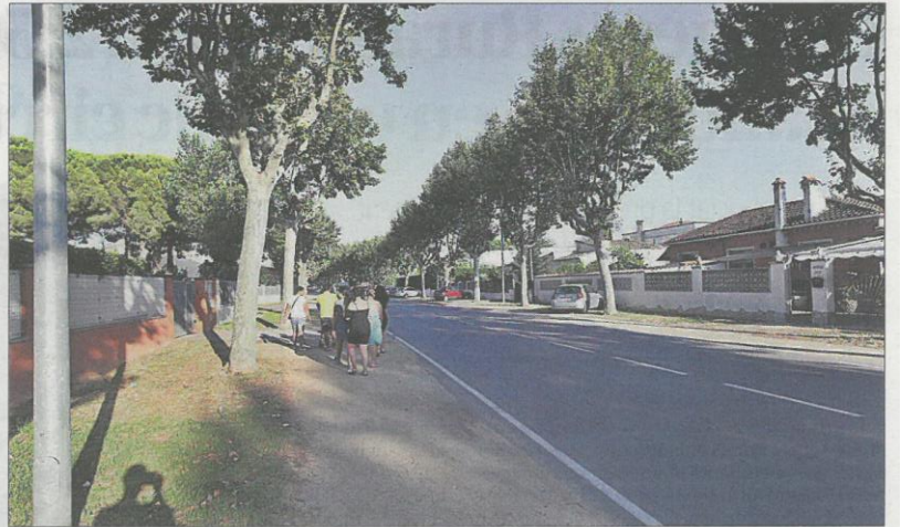
El tram d'avinguda on es faran les obres d'adequació de voreres.
