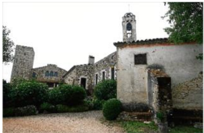
Vista exterior del Castell d'Empordà, que acull l'hotel d'alta
