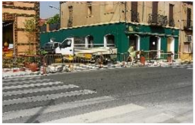
Treballadors arreglant un pas de vianants. ddg
