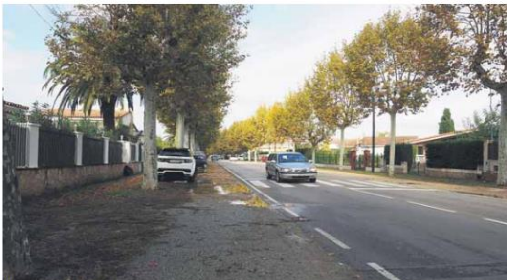
L'avinguda Marinada d'Empuriabrava, en un dels trams que s'han d'urbanitzar ■ JOAN PUNTÍ
