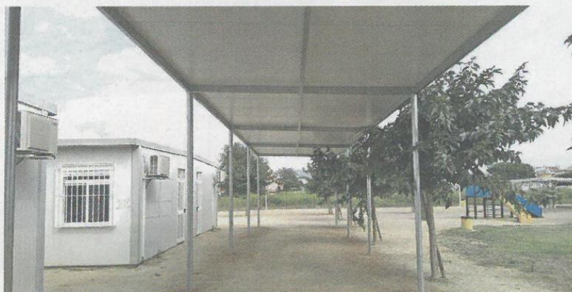
PROTEGITS DEL TEMPS. El pati de l'escola, amb el nou muntatge
