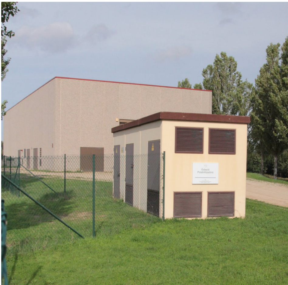
La potabilitzadora de Fontanilles, al Baix Ter Foto: E.A.
