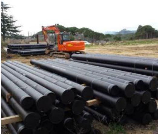
Palamós inicia les obres per portar aigua a Castell
