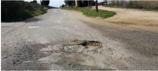
Un tram del camí d'accés a Castell en el seu estat actual.
