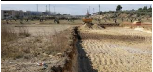
Els treballs de moviment de terres per la futura zona esportiva.
