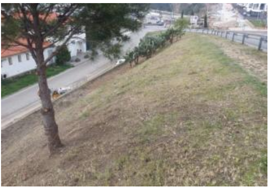
Palamós Neteja i condicionament d'un talús
