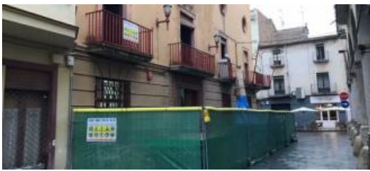
La Bisbal Inicien les obres a l'ajuntament vell
