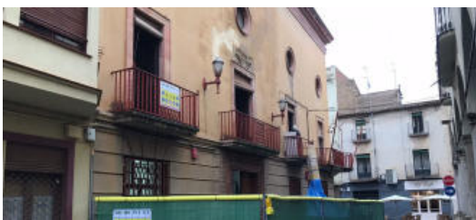
La Bisbal inicia les obres per reconvertir l'antic ajuntament en un centre de serveis
