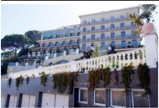
Imatge del setembre de 2013 d'obres a l'aleshores Hotel Bellevue, ara Hotel Montjoi.
