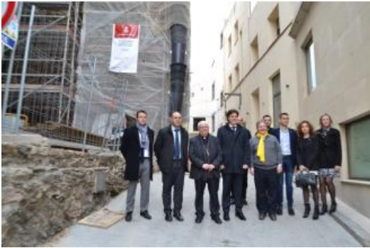
El bisbe de Girona visita a Llançà les obres de la Torre de l'Abat
