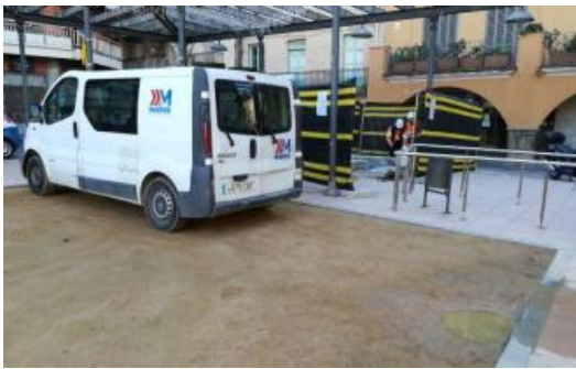
Imatge de l'inici dels treballs.
