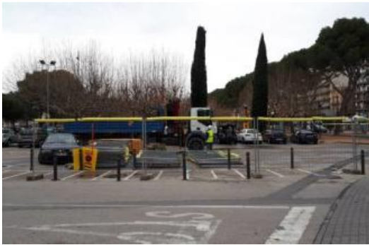
Imatge de l'inici dels treballs al moll del Fortí.
