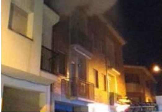
Imatge del pis afectat.
