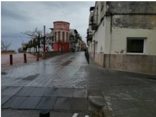
Tram del carrer del Pedró que se sotmet a obres.
