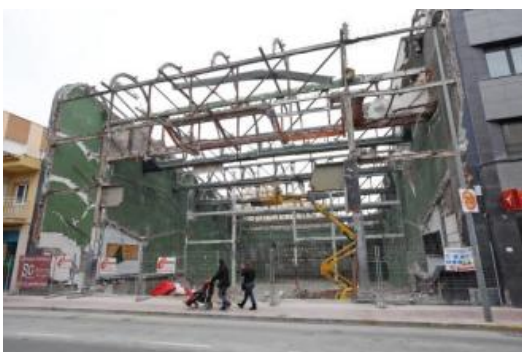
L'esquelet estructural del que havia estat el cinema Kyton.
