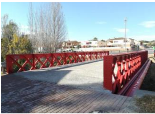
El pont de Ferro, ja restaurat.
