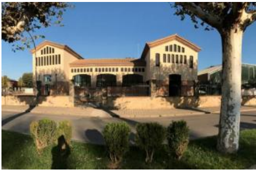
L'antic escorxador, amb la imatge rehabilitada després de la intervenció perquè aculli la biblioteca local.
