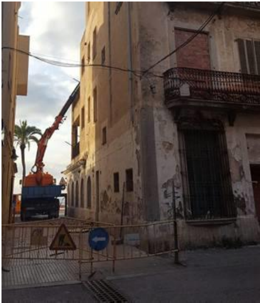
Els treballs d'enderroc van començar ahir al matí.
