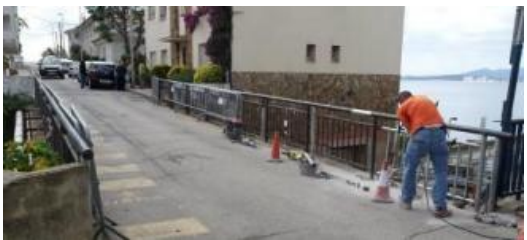
Imatge de la realització dels treballs.
