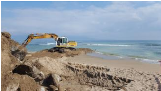
Una màquina, treballant a la platja de Sant Pere.
