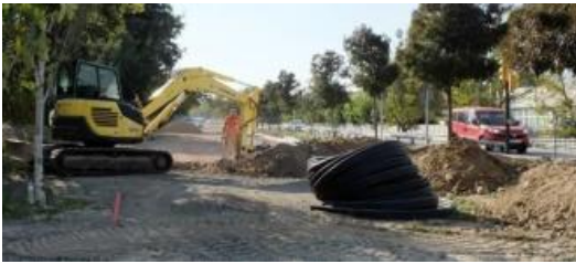
Operaris treballant a l'aparcament paral·lel a l'N-260.
