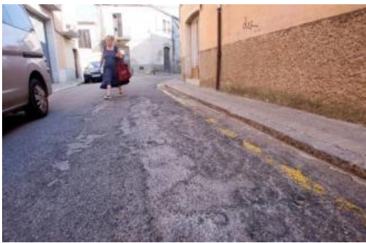
El carrer Llarg s'asfaltarà i es reformarà.
