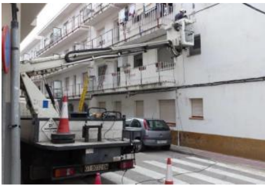
Un operari treballant en les tasques de renovació de l'enllumenat.
