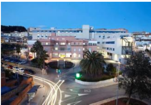
L'hospital de Palamós, en una imatge d'arxiu.
