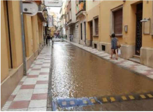
Imatge del carrer Sant Domènec, parcialment inundat.
