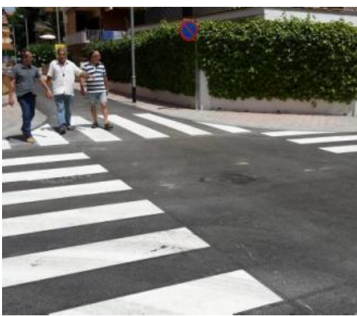
Visita d'obres al Palmar.
