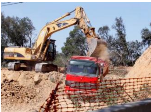
Màquines treballant a la carretera de Bescanó, a l'abril.
