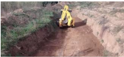
Execució d'un tram del circuit, ara ja sense activitat.
