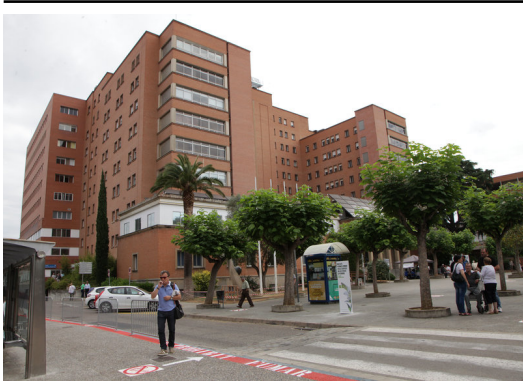
L'ospital Josep Trueta, situat actualment a la zona de Sant Ponç, al nord de Girona Foto: J.S.
