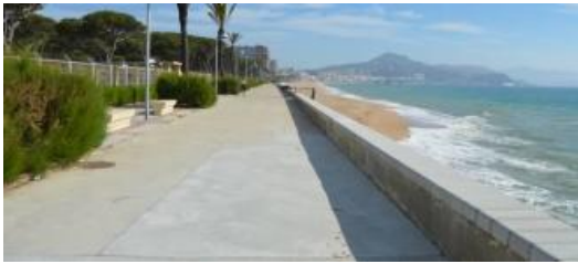
L'esvoranc del passeig de Blanes ja està reparat
