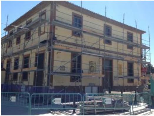
Les obres de rehabilitació de Torroella
