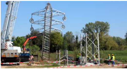
Operaris d'Endesa aixecant un dels suports de la nova línia de 110 kV entre Juià i Bellcaire
